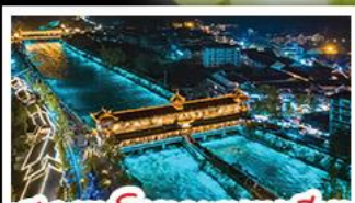
สะพานปิรามิดแดนหมี่เฉียว
