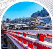
สะพานนากะบาชิ
