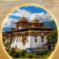
พุนาคาซอง
