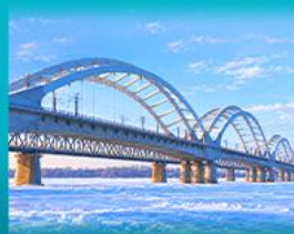
สะพานรถไฟโปนิว
